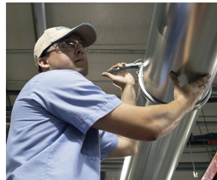
Le raccord QF se serre en quelques secondes, sans recourir à des soudures, boulons, vis, brides, outils spéciaux, mesures précises ou compétences spécialisées.
