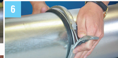
Enclencher le collier de serrage sur le joint torique et une extrémité du raccord.
