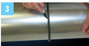
Utiliser le joint torique fourni et marquer le conduit pour la coupe.
