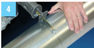
Percer un trou d'accès, puis couper le conduit avec une scie.
